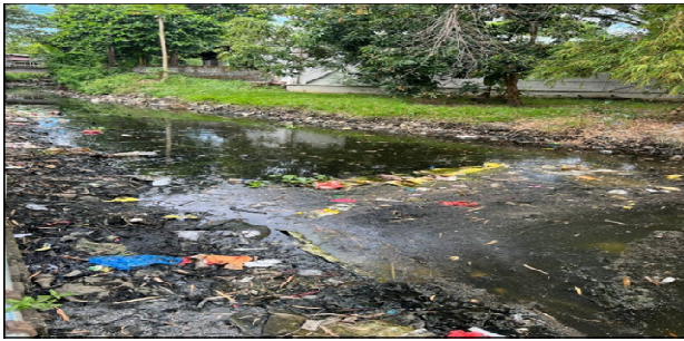
Fig. 7 Brgy. Sto. Tomas Creek
