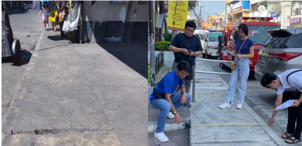
Fig. 4. Sidewalk 3 Fig. 5. Sidewalk 4
