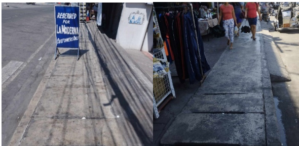
Fig. 8. Sidewalk 7 Fig. 9. Sidewalk 8
